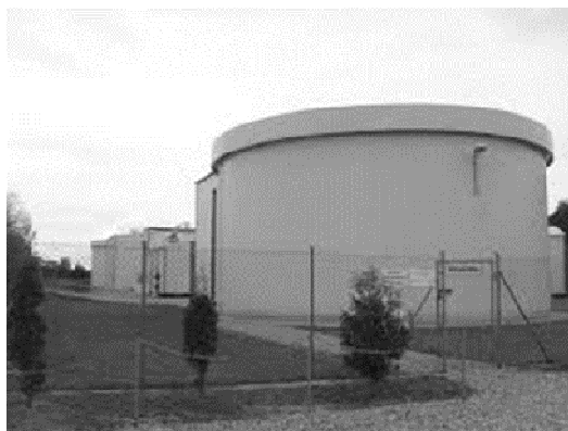
Rys. 9. Komora fermentacyjna biogazowni rolniczej w Pawłóoku (Komora fermentacyjna 2010)
