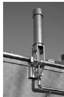
Rys. 10. Zbiornik na biogaz a) oraz pochodnia do awaryjnego spalania biogazu b) (Zbiornik biogazu 2014, Pochodnia awaryjna 2014)
