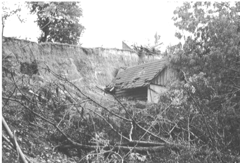
Rys. 2. Nisza osuwiska „FALKOWA” bezpośrednio po jego uaktywnieniu Fig. 2. Landslide headwall directly after its activation
